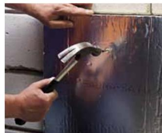
**4.** Прикрепите изоляционную плиту парой гвоздевых дюбелей, а к стене с деревянным каркасом – шурупами. Плиты устанавливаются маркированной стороной наружу.
