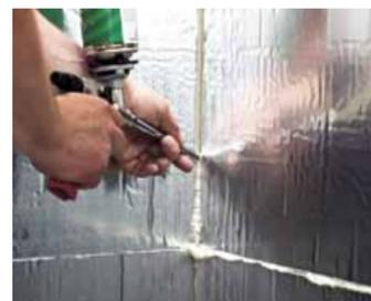
**6.** Герметик наносится во все места примыканий изоляционных плит, а также в местах «проходок» сквозь изоляцию (трубы, эл. розетки, кабель и т.п.).
