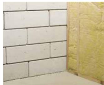
**1.** Плиты SPU Sauna-Satu могут использоваться для изоляции как каменных, так и деревянных конструкций.
