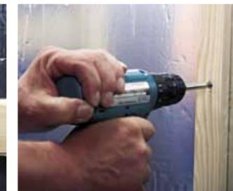
**11.** Прикрепите направляющие рейки (для крепежа лицевых панелей) сквозь изоляцию с помощью гвоздевых дюбелей или шурупов. Используйте рейки толщиной не менее 20 мм для создания воздушного зазора между изоляцией и облицовкой.
