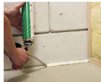
**2.** Начните монтаж плит с нанесения герметика на чистую и очищенную от пыли поверхность пола. На реставрационном объекте крепление изоляционной плиты может быть альтернативно начато также с верхней части старого цоколя.
