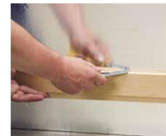
**12.** Для установки гидроизоляции выполните надрез на алюмоламинате (рекомендуется 15–20 см от пола).
