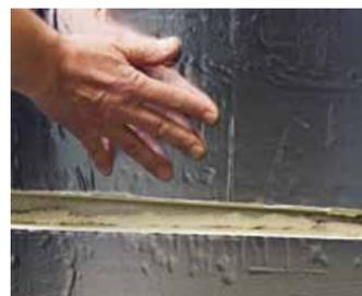
**7.** Установите следующую плиту, когда на шпунт будет нанесен герметик. Благодаря соединению в «шип-паз» и герметику, швы будут герметичными.
