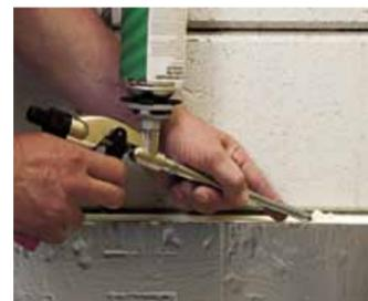
**5.** До установки следующей плиты нанесите на шпунт герметик. Плиты можно устанавливать как короткой так и длинной стороной, соблюдая принцип «шип-паз».
