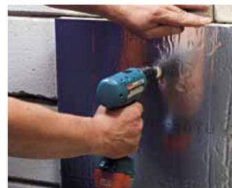
**3.** Установите первую плиту по уровню горизонтально пазом вверх, предварительно срезав ножом шип с противоположной стороны плиты, устанавливаемой на пол.
