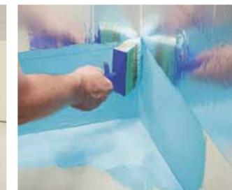
**14.** При необходимости нанесите на поверхность изоляции праймер в соответствии с инструкцией производителя гидроизоляции. Уложите гидроизолятор на плиту SPU Sauna-Satu.
