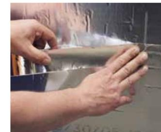
**9.** На все стыковые соединения плит, мест примыканий и проходов, крепежа нанесите алюминиевый скотч.
