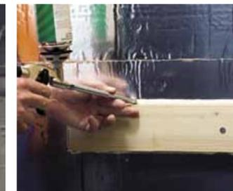
**10.** Вырежьте из изоляционной плиты кусок, чуть больший опорной доски. Вставьте опорную доску (полки) сквозь изоляционную плиту к стене и нанесите на швы герметик.
