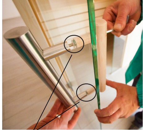
Inserir as anilhas planas de plástico no puxador de aço inoxidável
